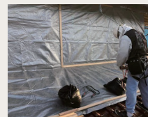
窓や壁などの目張り
