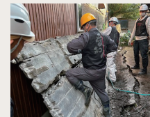
ブロック塀の解体
