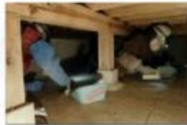
床下に入るときは安全確保のため、換気をし、2人以上で作業をします
