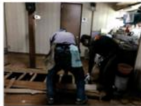
床下に入るときは安全確保のため、換気をし、2人以上で作業をします
