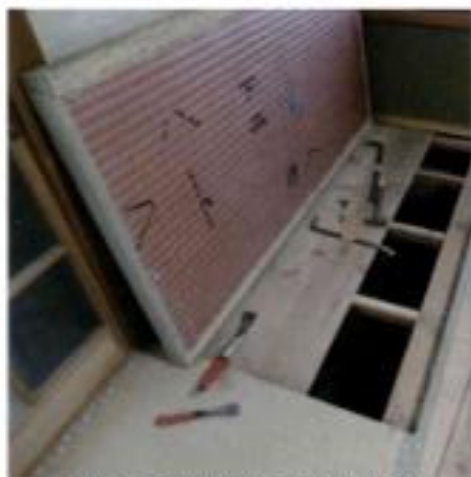
和室の床板をはがす(写真①)
