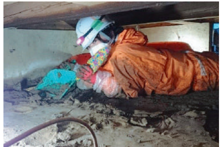
床下の泥だしの様子
